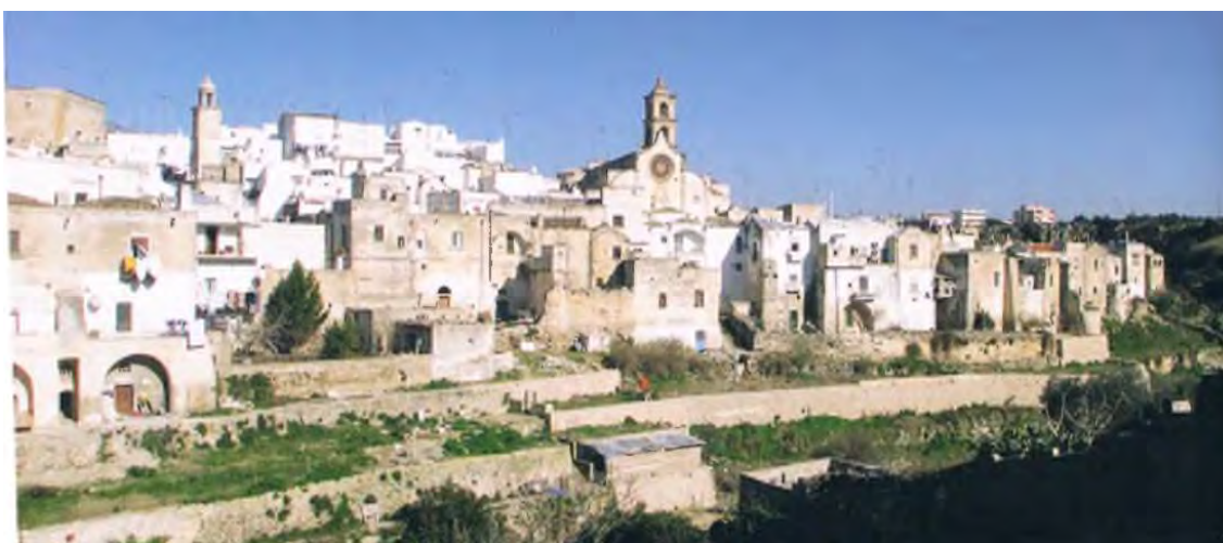
Fig.12: Veduta del centro storico di Laterza– Area Omogenea A –
